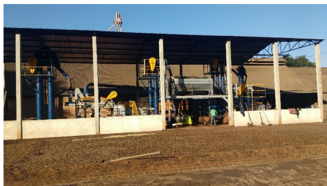
Figura 9: Via Úmida (vista frontal)
